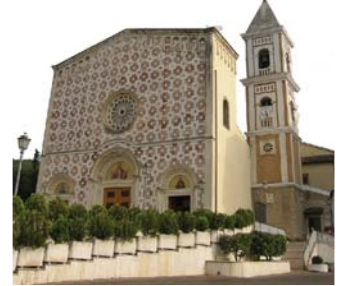
CHURCH OF THE VOLTO SANTO DI MANOPPELLO
